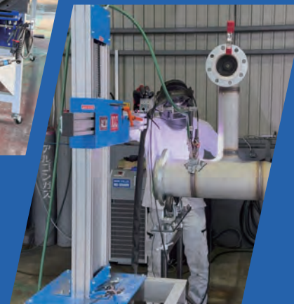
製作工程【溶接】
