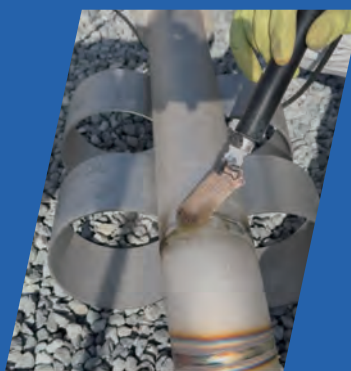
製作工程【スケール除去】
